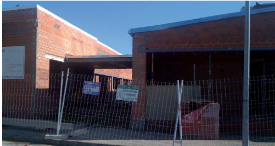
Obras de construcción de la Residencia de Ancianos.
