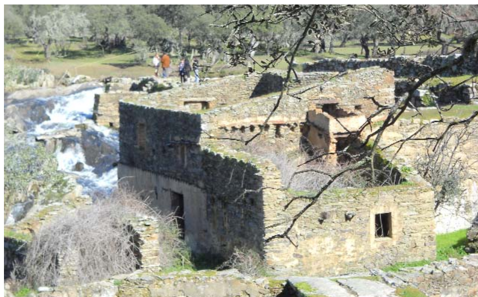
Paraje del Molino de la Dehesa, en Botija, que se rehabilitará con el taller de empleo Tamuja.
