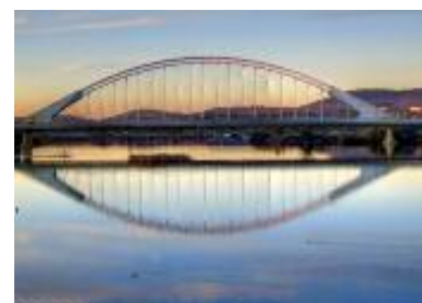
El Guadiana a su paso por Mérida
