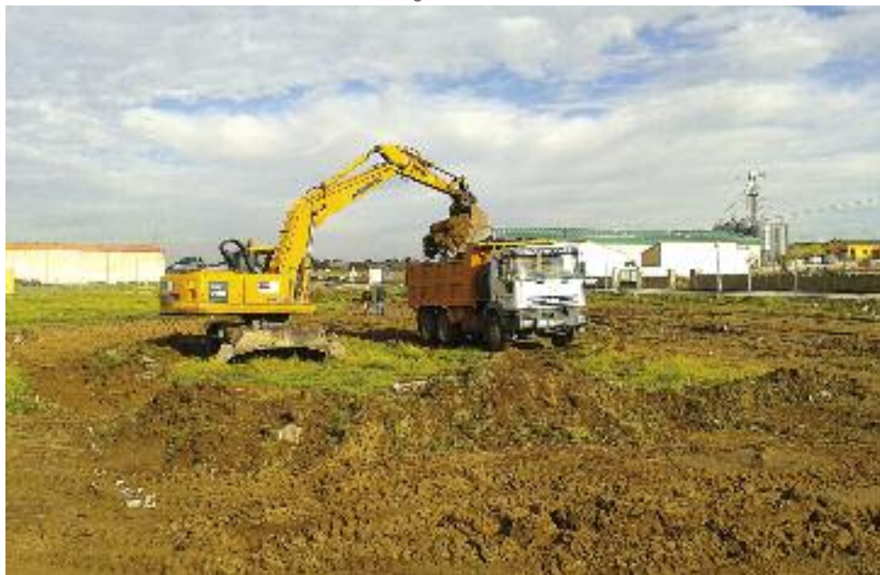
Obras de construcción del Centro Asistido San Agustín.
