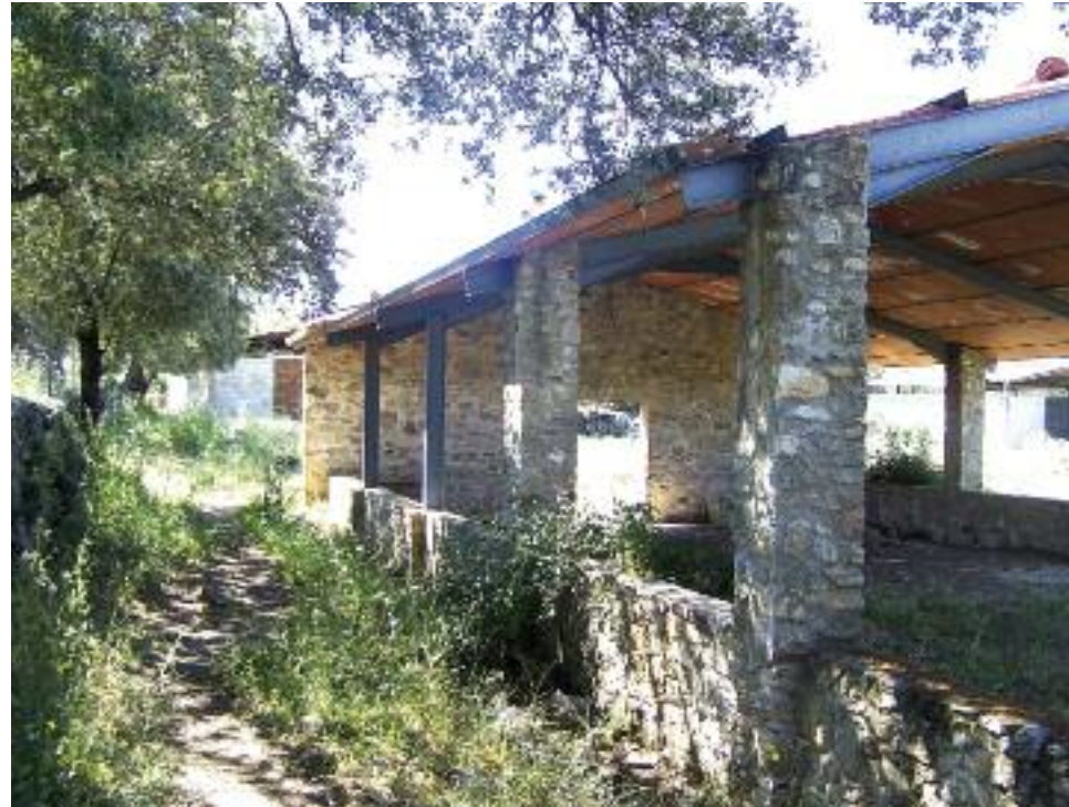
Obras de la Casa de la Cultura de Salvatierra, realizadas con material típico de la zona.
