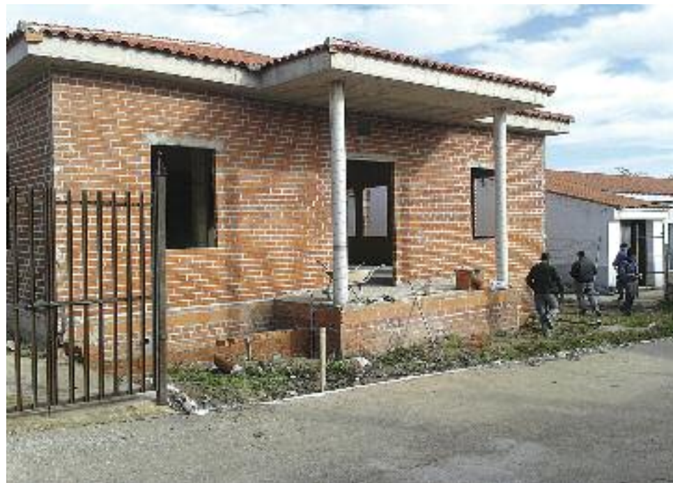
Segunda fase de la construcción del Centro de Ocio.
