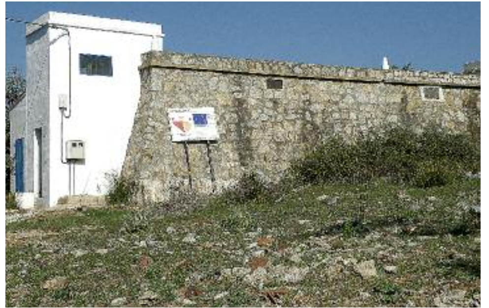
Imágenes superiores: río Ayuela y depósito de agua. Al lado, Charca de Los Hermanos. Debajo, puente sobre el Ayuela.
